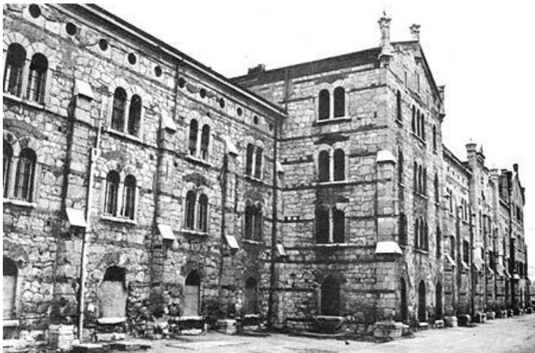
L'edificio per la produzione del pane e delle gallette, in una fotografia degli anni settanta del Novecento
