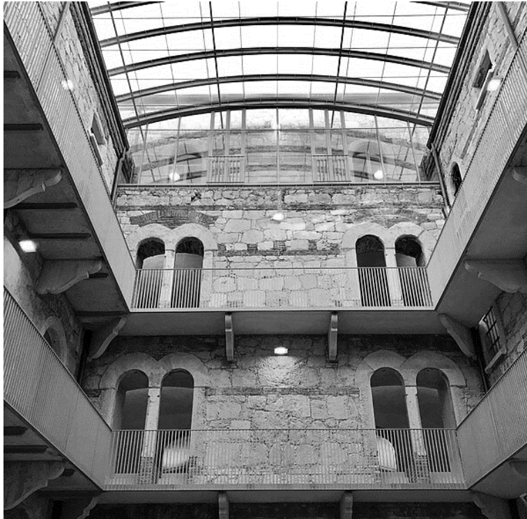
Una delle corti interne del panificio, coperte da una struttura vetrata a seguito dei restauri progettati da Massimo Carmassi.
